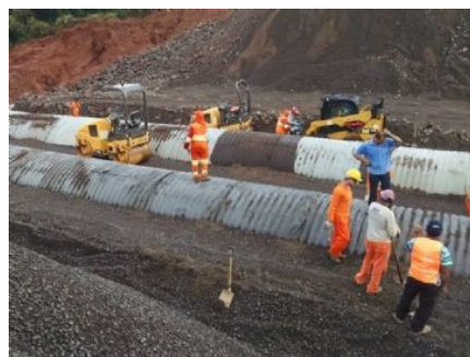
Obras de recuperação prosseguem no km 49
